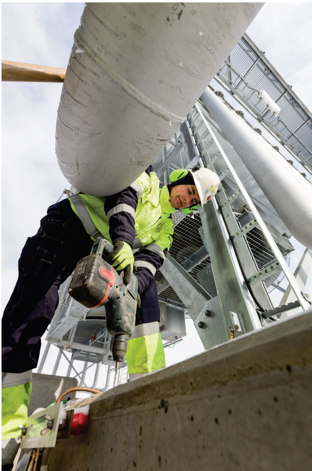
Foto: MEDVIND/Bent Sørensen Anlægsarbejde på ny kompressorstation i Egtved
