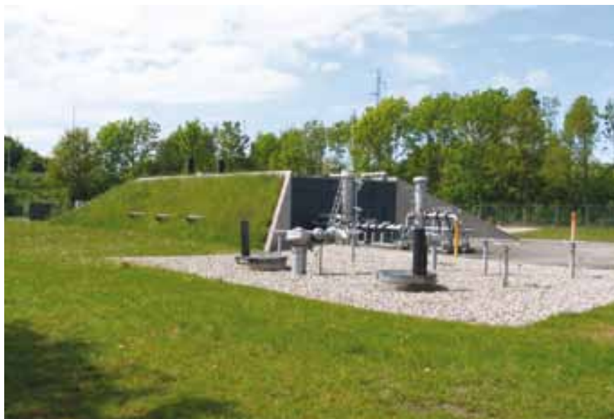
Figur 6-5: M/R-station, her kombineret med en L/V-station, der ses i forgrunden.
