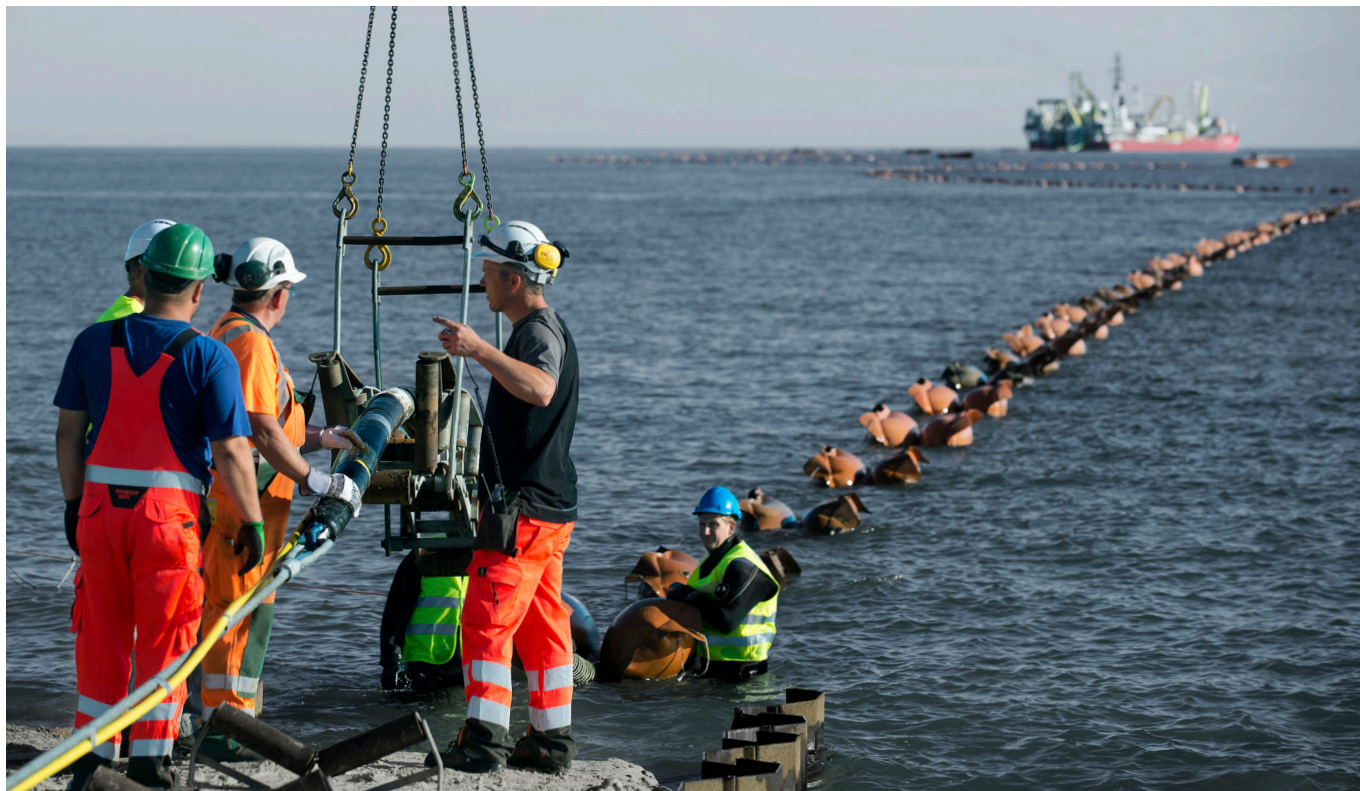
Fra tidligere anlægsprojekt – her ilandføring af søkabel til Skagerrak 4-forbindelsen til Norge.
