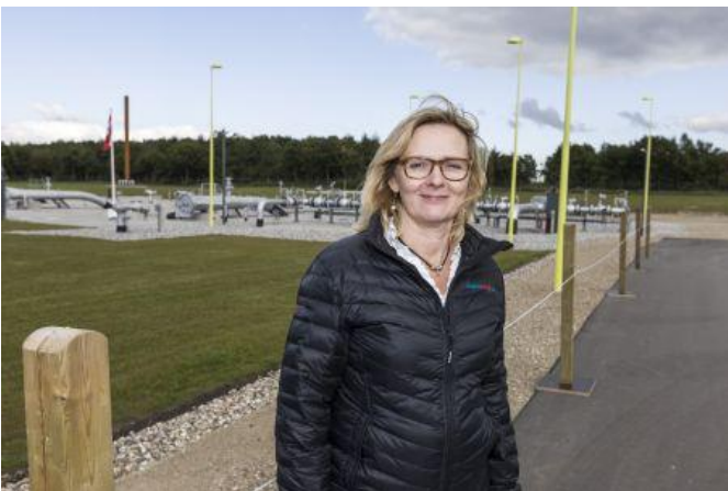
Projektleder, Nina Vendelboe foran kompressorstationen i Egtved, Foto: Medvind/Bent Sørensen.
