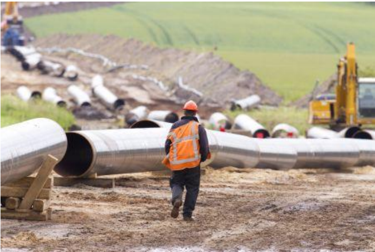
Anlægsarbejder på Egtved-Ellund-rørledningen. Foto: Medvind/Bent Sørensen
