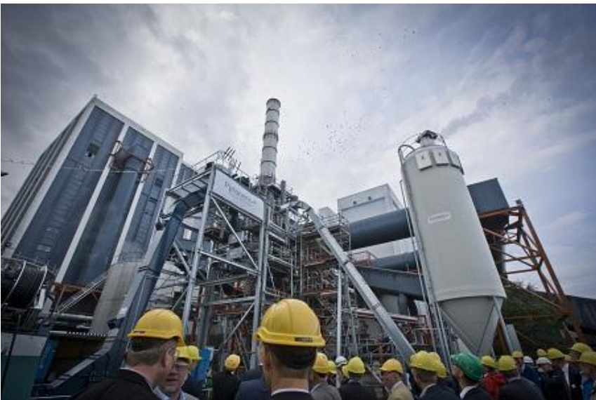
DONG Energy's forgasningsanlæg Pyroneer i Kalundborg. Kilde: Dong Energy.
