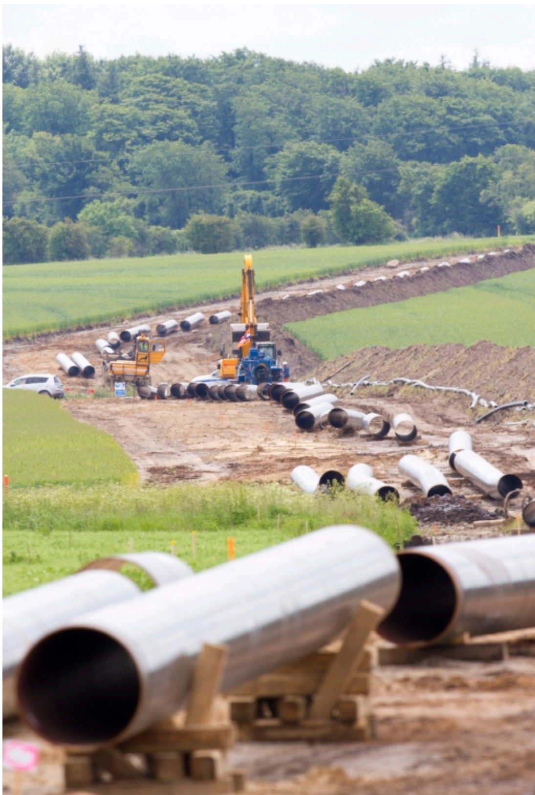
Anlægsarbejde på ny gasrørledning Ellund - Egtved
