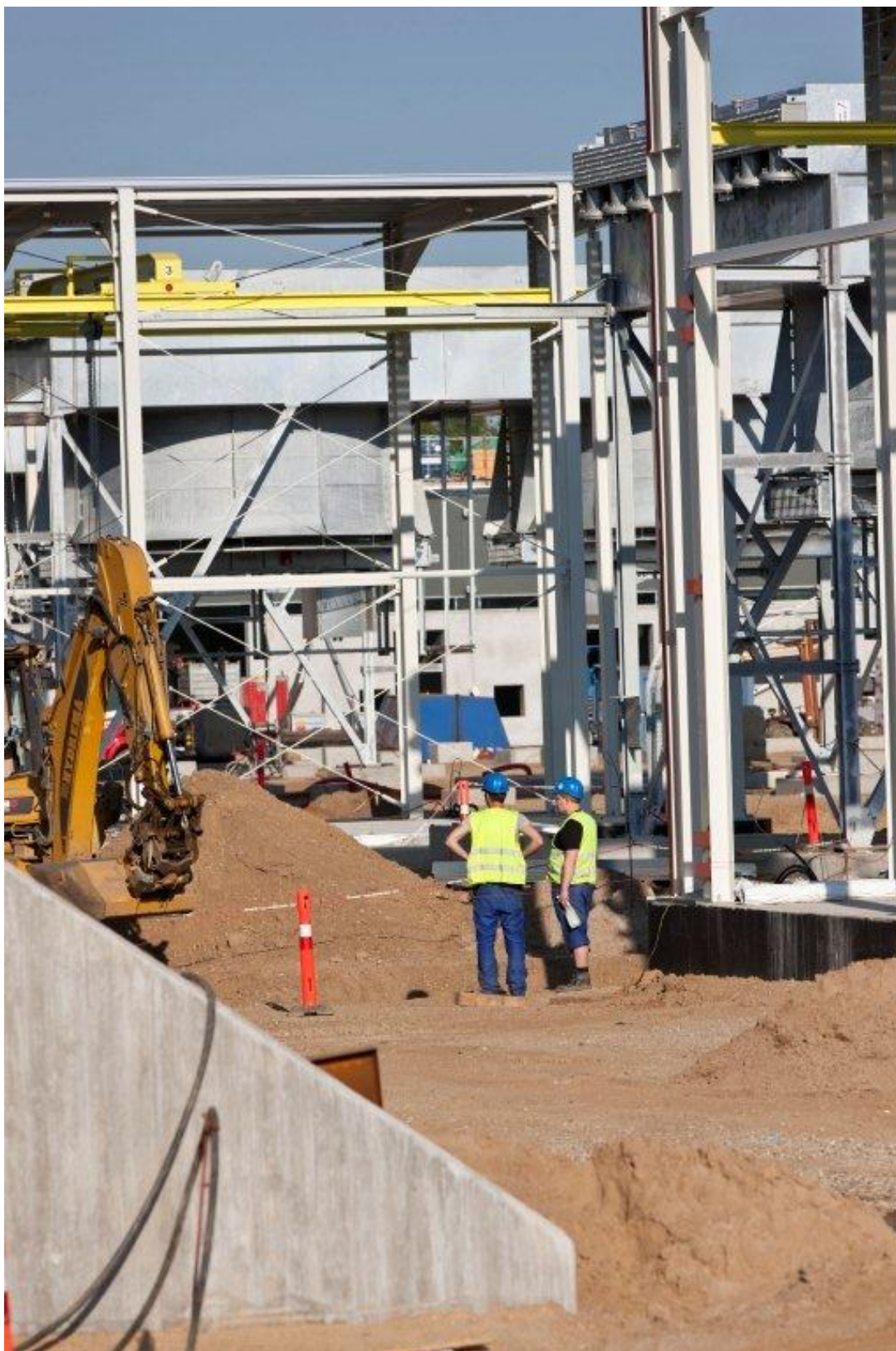
Anlægsarbejde på ny kompressorstation i Egtved
