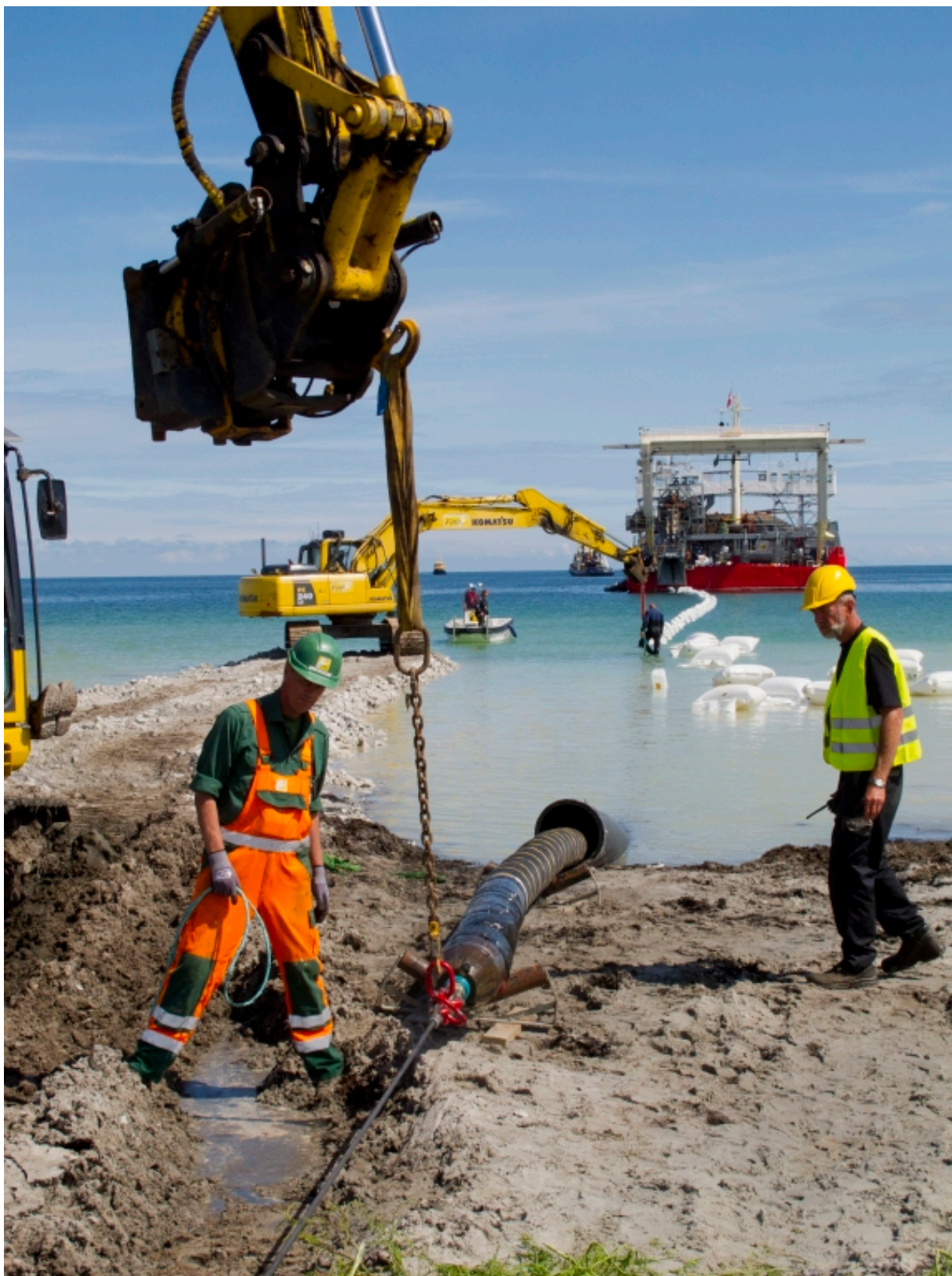
Anholt Anlægsprojekt - 220 kV søkabel i Kattegat
