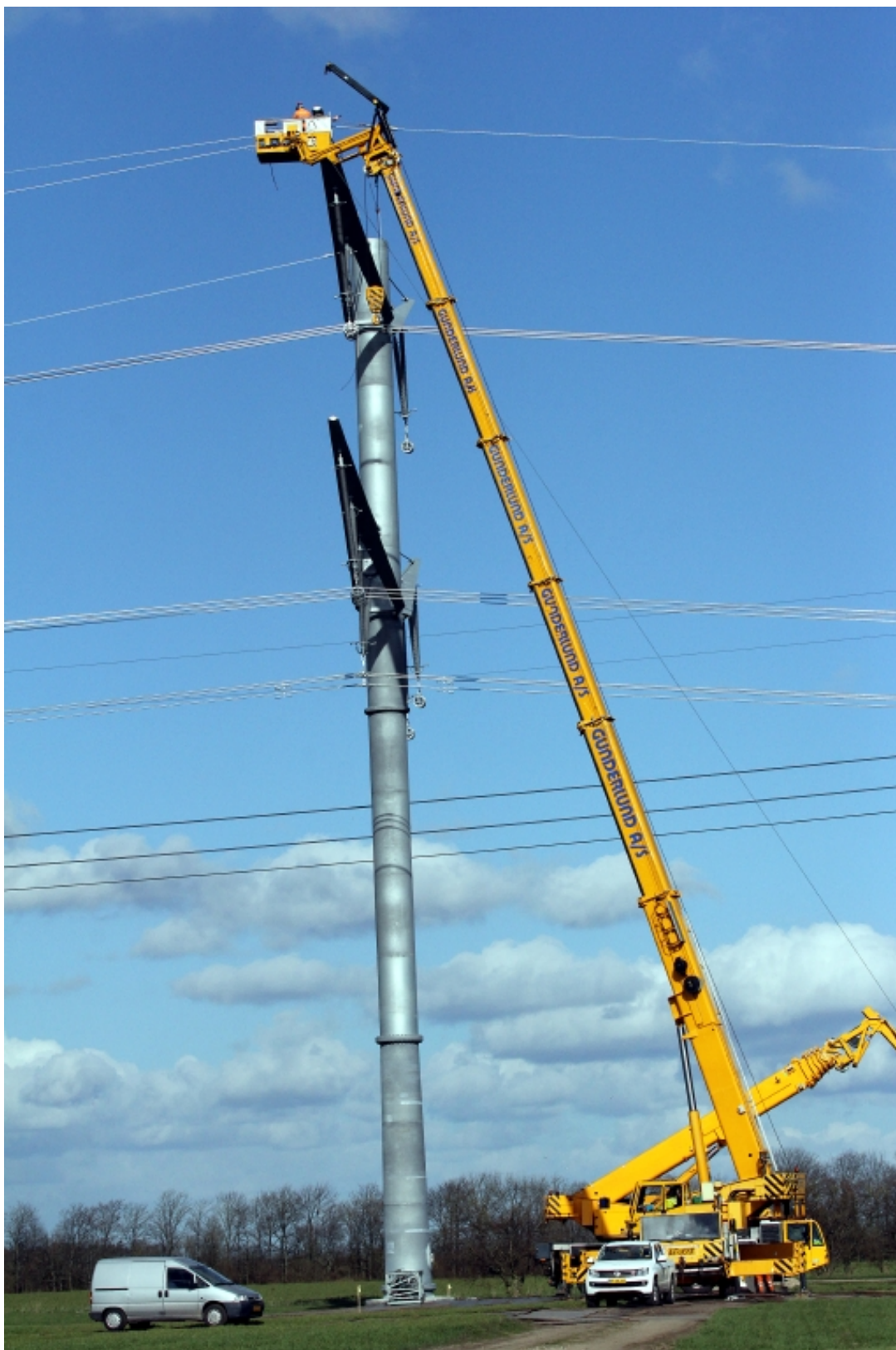
Kassø-Tjele – Kabler trækkes og isolatører monteres
