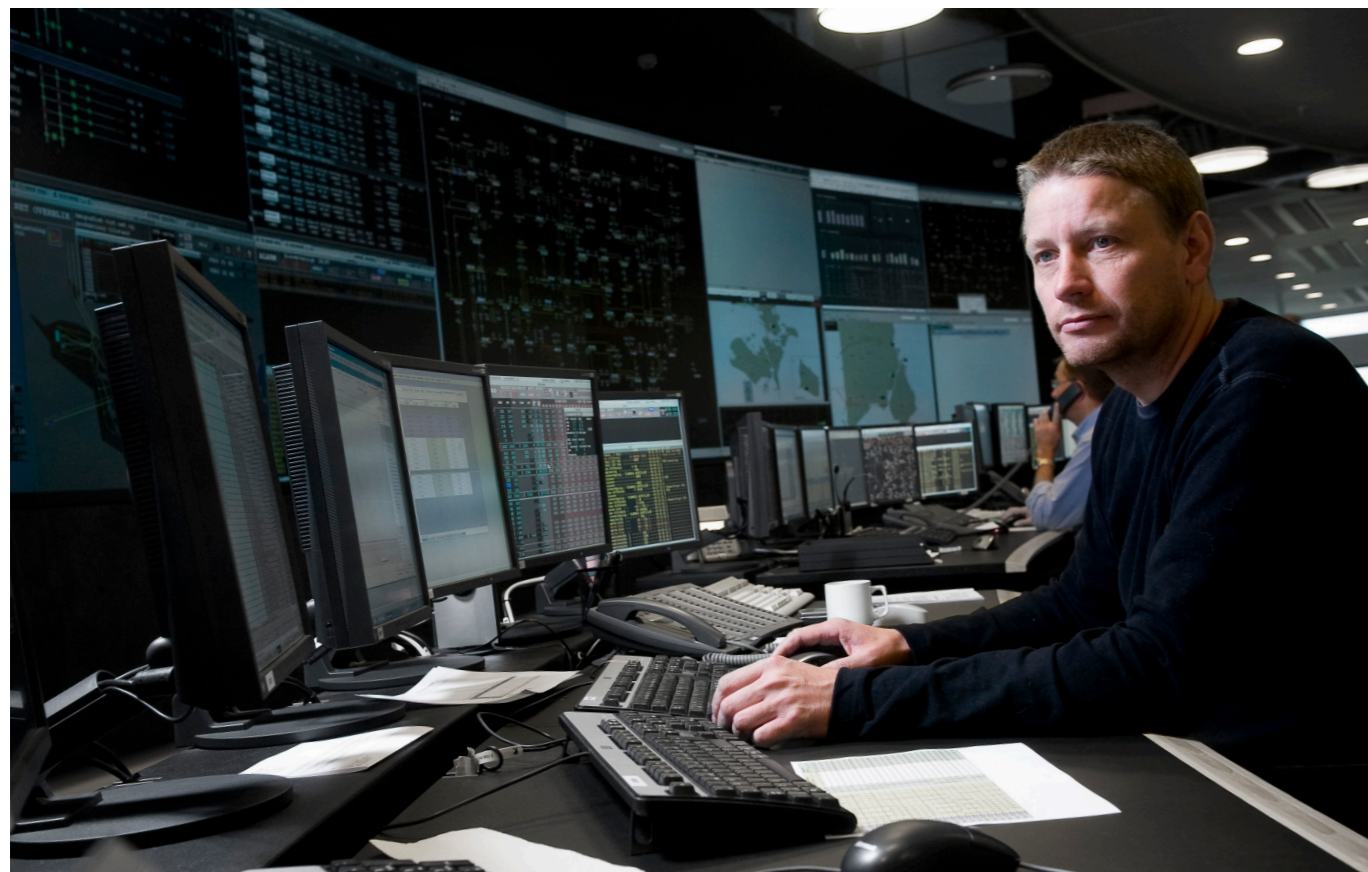
Energinet's Kontrolcenter El i Erritsø.
