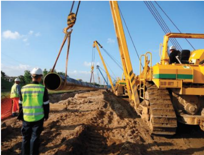
Nedlægning af nyt gasrør.
