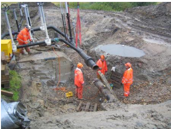
Indsvejsning af ny ventilstation ved Sejling Hedevej.
