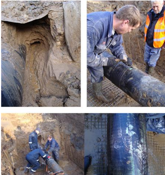
Reparationsarbejde på en ledning efter gennemført pigging.
