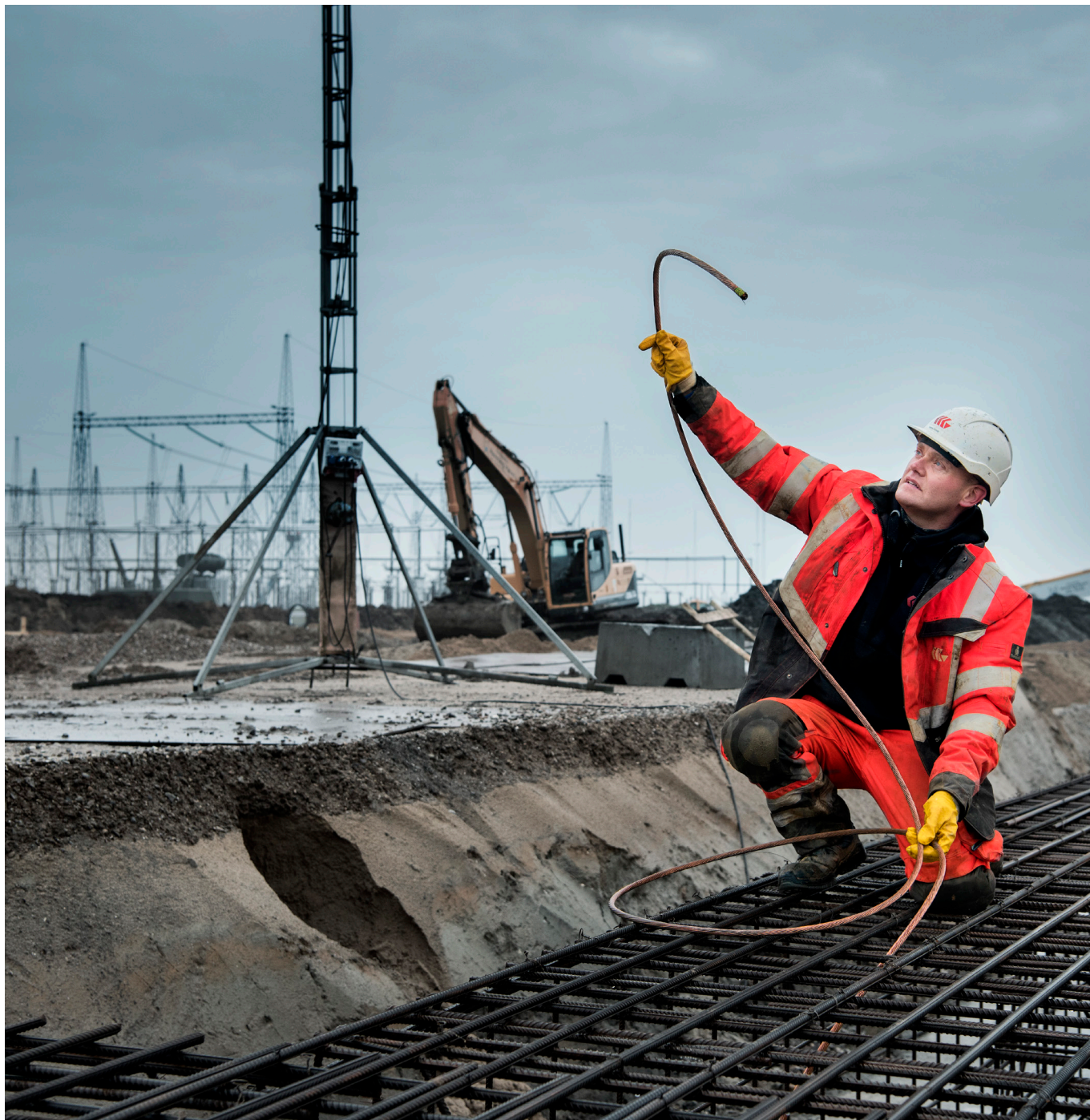
Etablering af COBRACable på station Endrup i Vestjylland.
