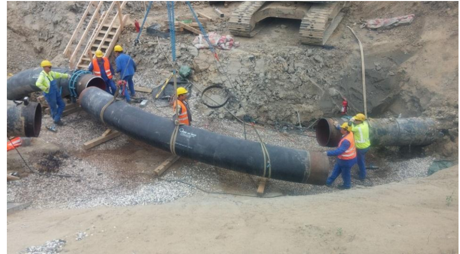
Tilpasning af overgangsstykke mellem det eksisterende rør og omlægningen. Foto: Steen Hoffmann.
