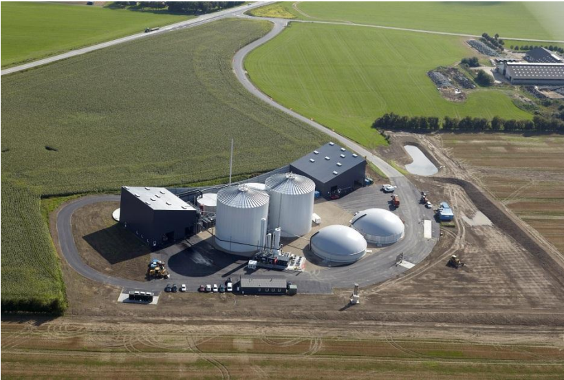
Bionaturgasanlæg hos Horsens Biogas tilsluttet DONG Energys gasdistributionsnet i Østjylland. Opgraderingsanlægget ses i container med tre søjler nærmest på billedet. Idriftsat oktober 2014. Foto: Jørgen Weber.
