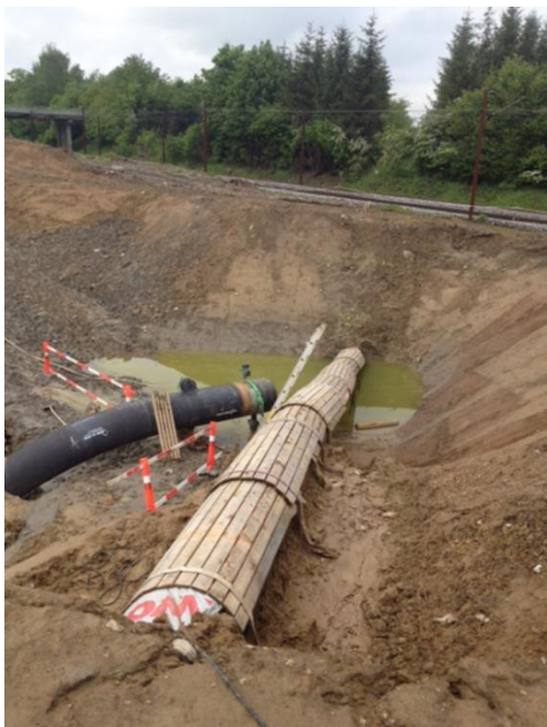
Arbejdet på transmissionsledningen på Sjælland varede i syv dage. Foto: Steen Hoffmann.
