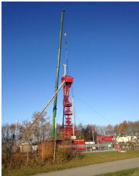
Udskiftning af brøndstrenge i pilotprojektet 2013. Foto: Torben Mortensen.
