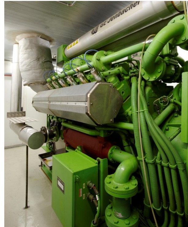
Biogasyret kraftvarmeanlæg, Energiselskabet Filskov.
