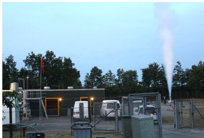
Gasafblæsning en tidlig morgen på måle- og regulatorstation Køge. Foto: Steen Hoffmann.
