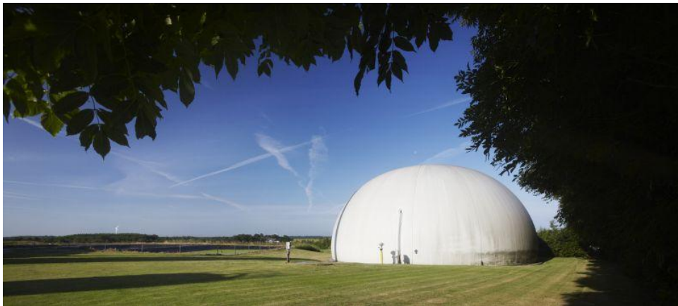
Biogasanlæg, Linkogas, Sønderjylland.
