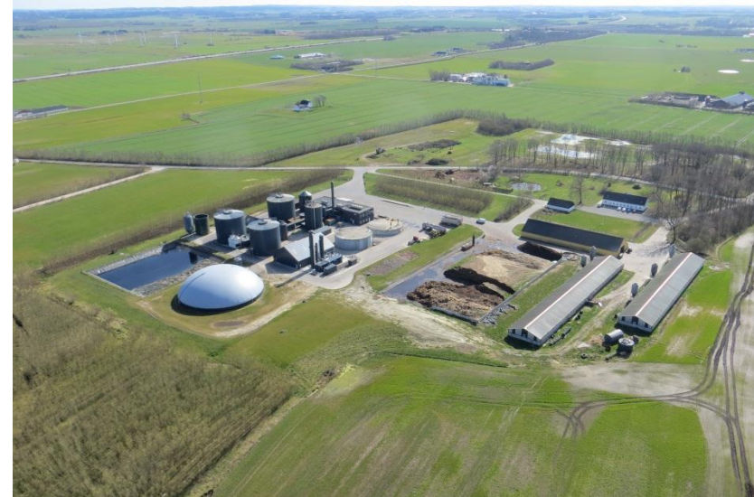
Bionaturgasanlæg hos LBT Agro som er tilsluttet HMN's gasdistributionsnet i Nordjylland. Opgraderingsanlægget er containeren med de tre søjler nærmest i billedet midtfor. I driftsat januar 2014. Kilde: LBT Agro.
