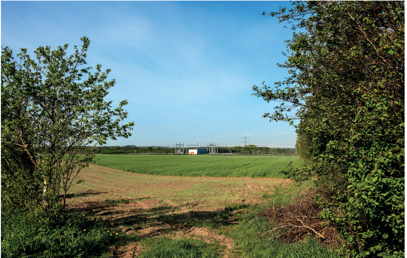
Højspændingsstationen i Revsing som den ser ud i dag.
