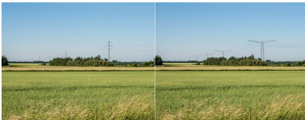
Figur 10 Venstre: Eksisterende 150 kV luftledning mellem Endrup og Idomlund.
