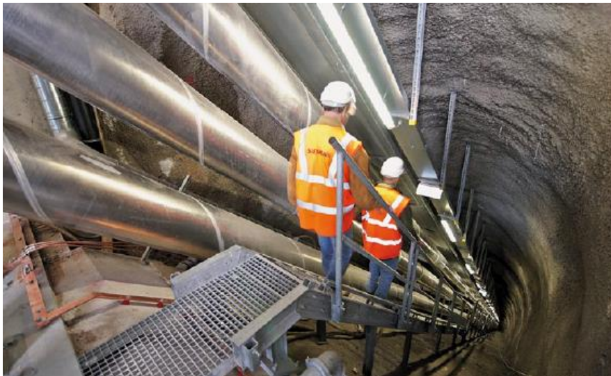
Figur 29 GIL installeret i tunneller (Siemens).
